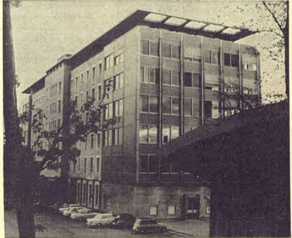
Le bâtiment principal, et à droite l'Aula, appelé « La grange » ou « La baleine ».
