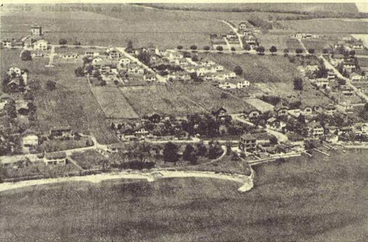
Saint-Sulpice, éparpillement de petites villas au gré de possibilités et de volontés d'ordre individuel privé ; destruction de la beauté du site et mort d'une communauté, négation de tout urbanisme
