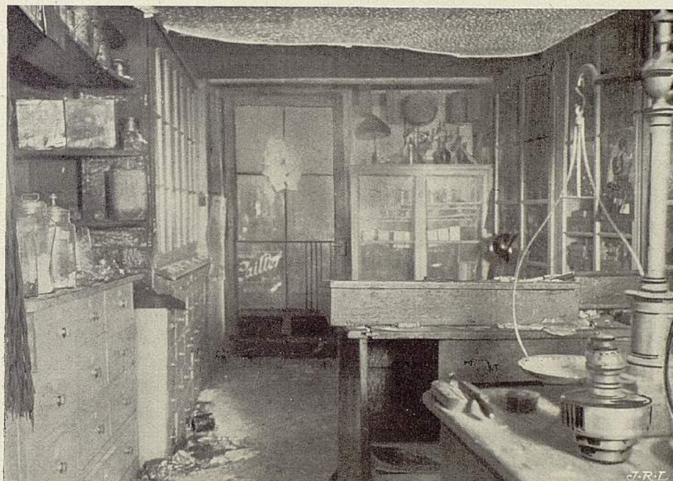
FIG. 59. — Le magasin A. X. pris depuis la cuisine. La photographie montre les deux foyers d'incendie.
