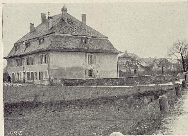
FIG. 64. — Photographie sur les lieux : les voies d'accès.
