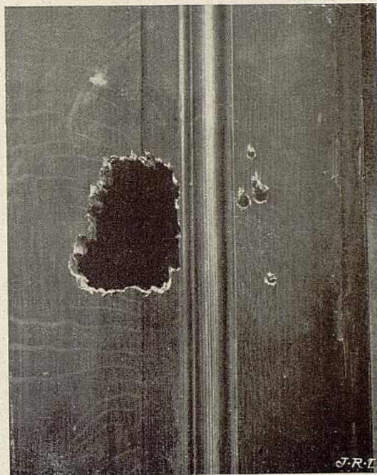
FIG. 26. — Détail de la figure 25 ; on voit nettement les trous du foret pour rechercher la targette.
