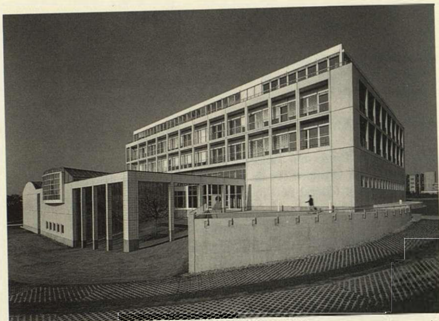
Façade est du bâtiment
