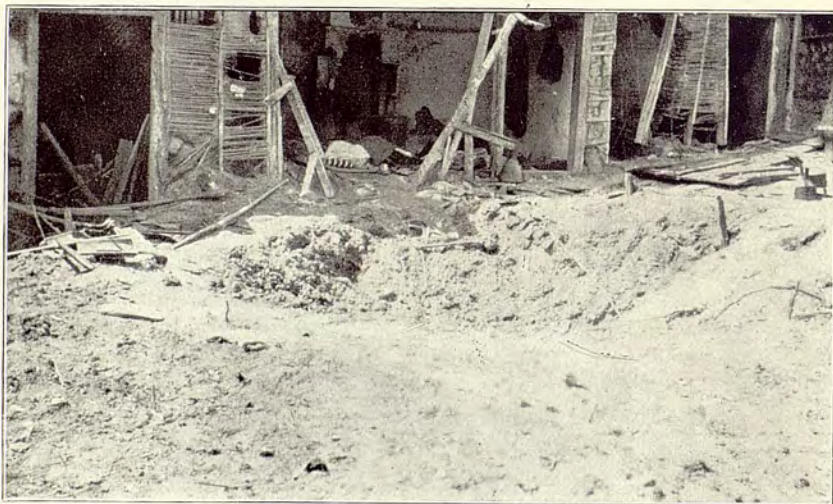
Bombardement de Vodena par avions : Une maison particulière éventrée par une grosse bombe. On voit l'entonnoir produit par son éclatement.
