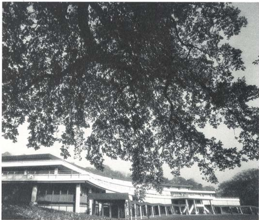
Le Bâtiment central de Dorigny
