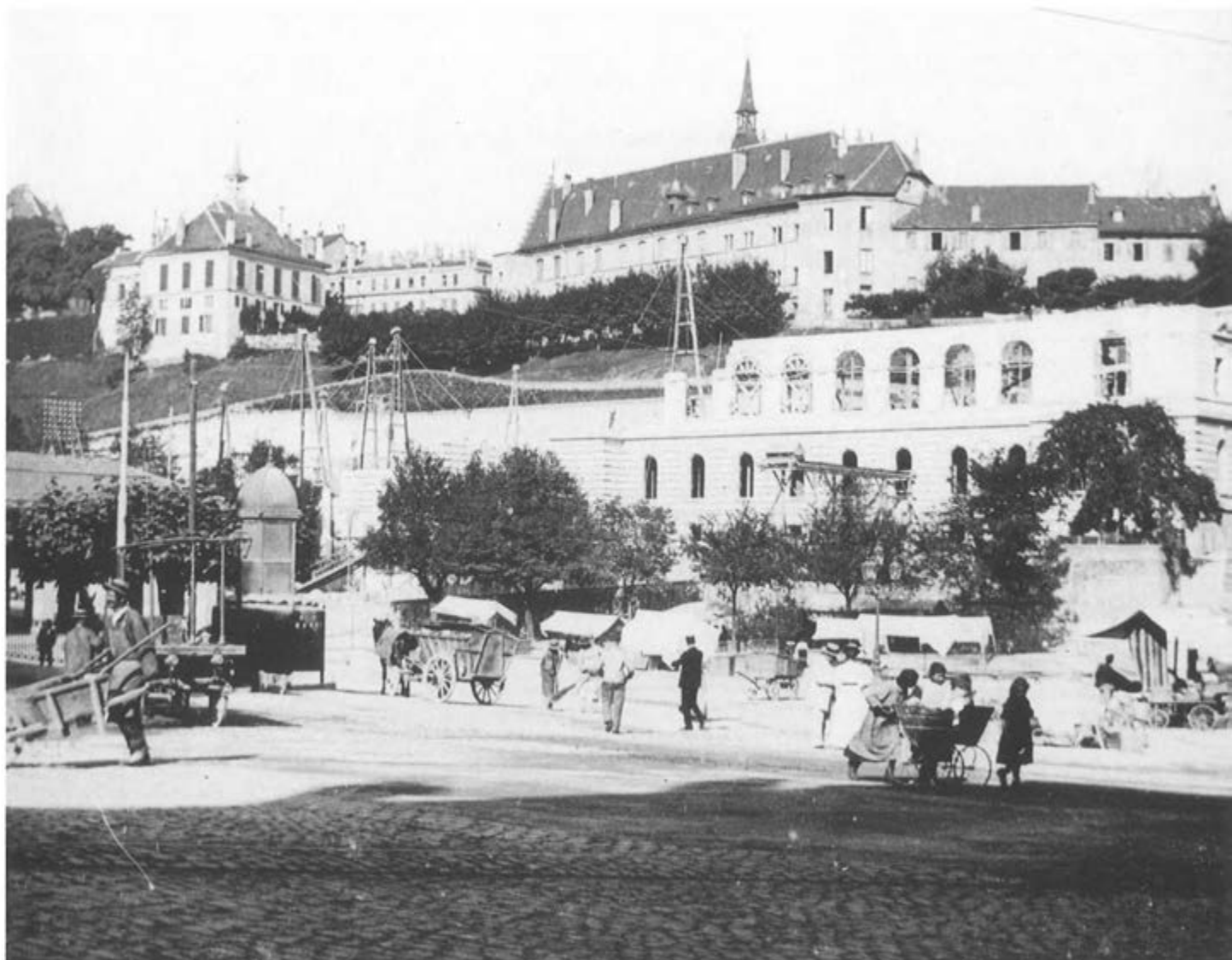
Place de la Riponne vers 1900: construction du Palais de Rumine [MHAE]
